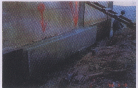
تغليف كمر الربط بعد التنفيذ
