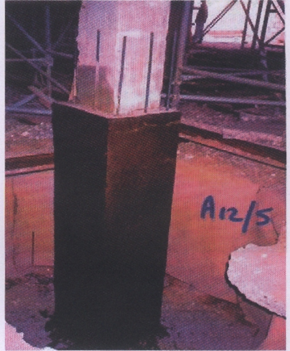
القميص الخرسانى وحماية السطح
