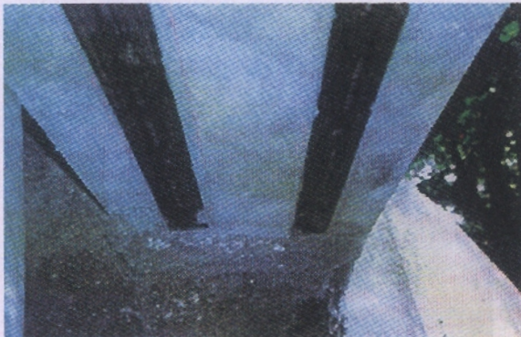
تنفيذ CFRP على جدران طابوق وجلاخات خرسانية
