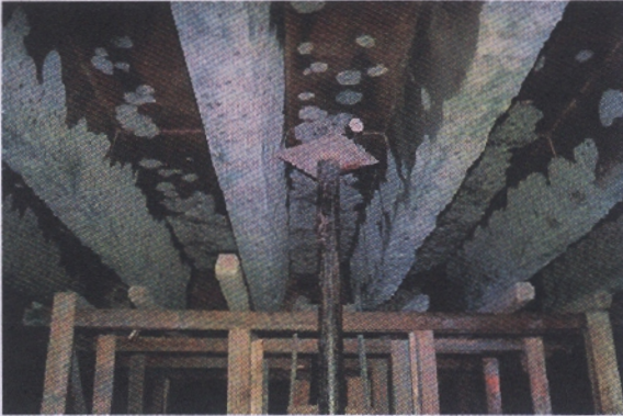
إزالة كافة الخرسانة المنهارة والسفع الرملي لجميع الأسطح المكشوفة
