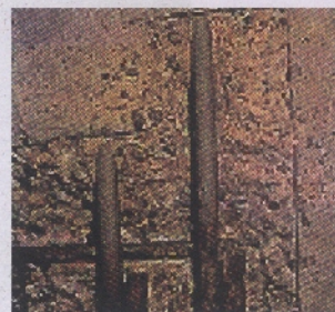
5- الكشف الكامل لحديد التسليح
