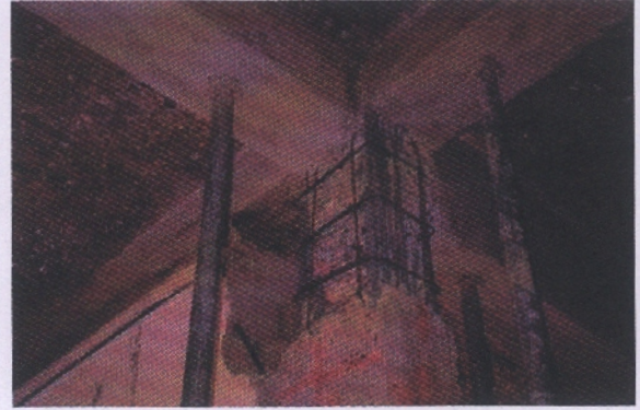
قطع الخرسانة المنهارة في قنطرة الكمر
