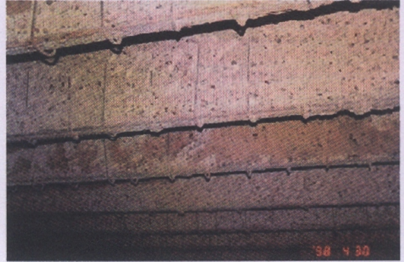
فصل تغطية الخرسانة بعد التضرر بالحريق
